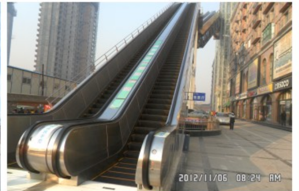
Shanghai Metro Project 上海地铁项目
