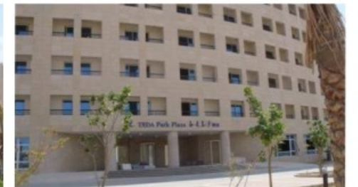
TEDA Park Plaza, Egypt 埃及泰达公园广场
