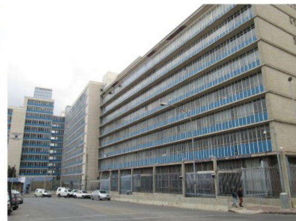
Johannesburg Central Police Station 约翰内斯堡中央警察局
